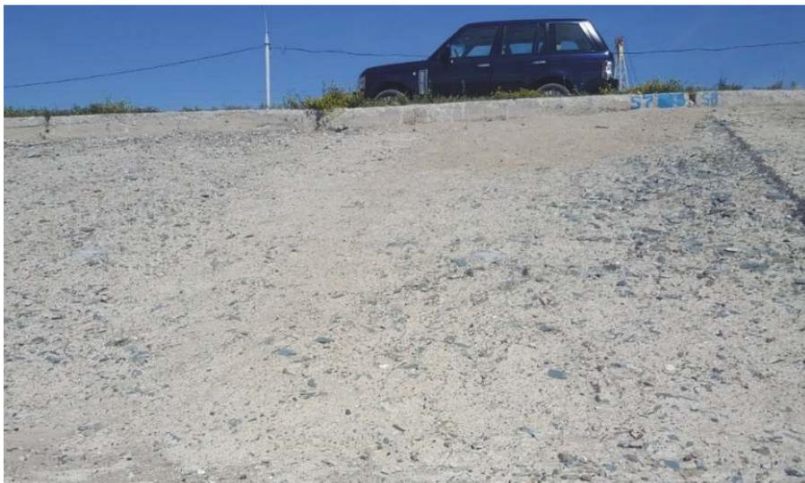
*Рис. 9.* Плиты крепления верхового откоса плотины Новосибирской ГЭС
